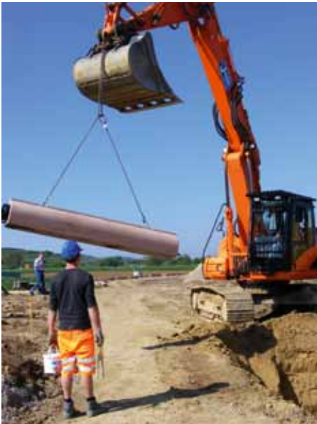
Errichtung des Schmutzwasserkanals mit dem System „Perfect Pipe“.
