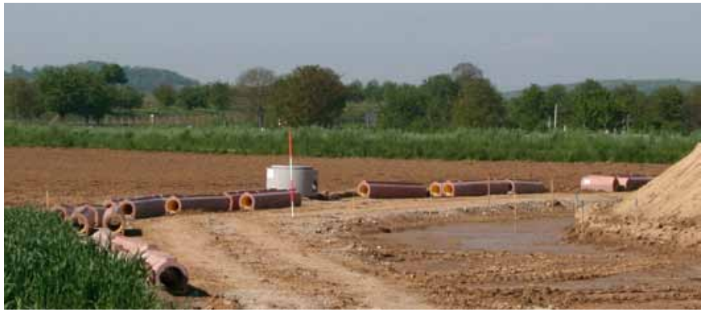
„Perfect Pipe“-Rohre vor dem Einbau auf der Baustelle.
