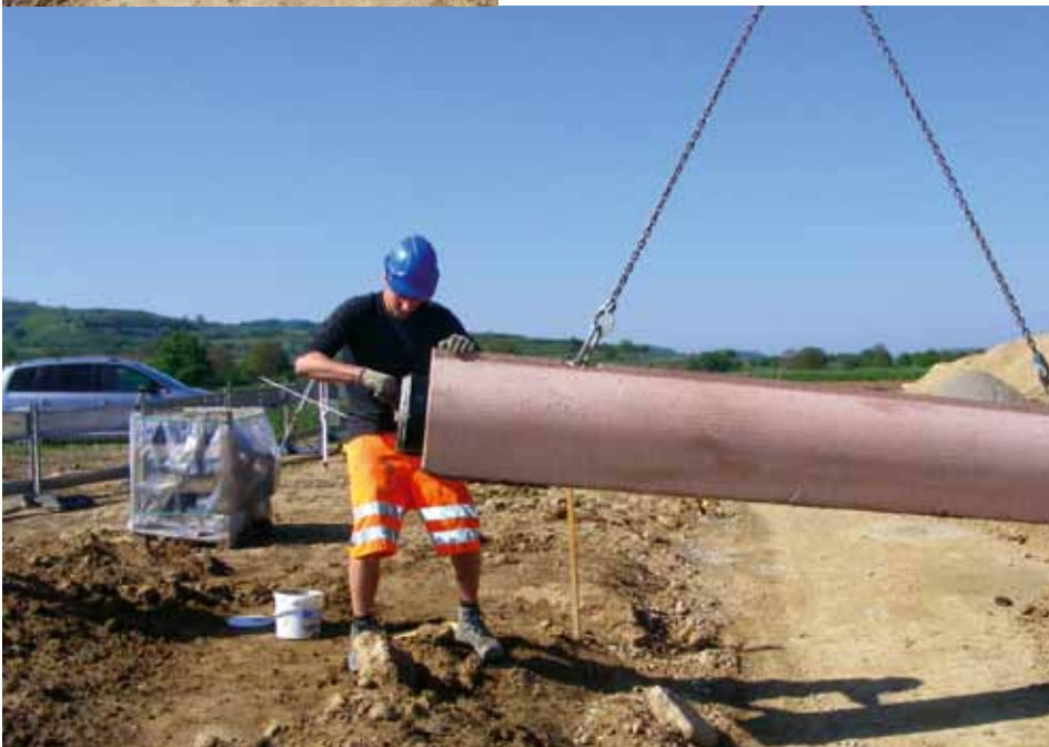
Errichtung des Schmutzwasserkanals mit dem System „Perfect Pipe“.
